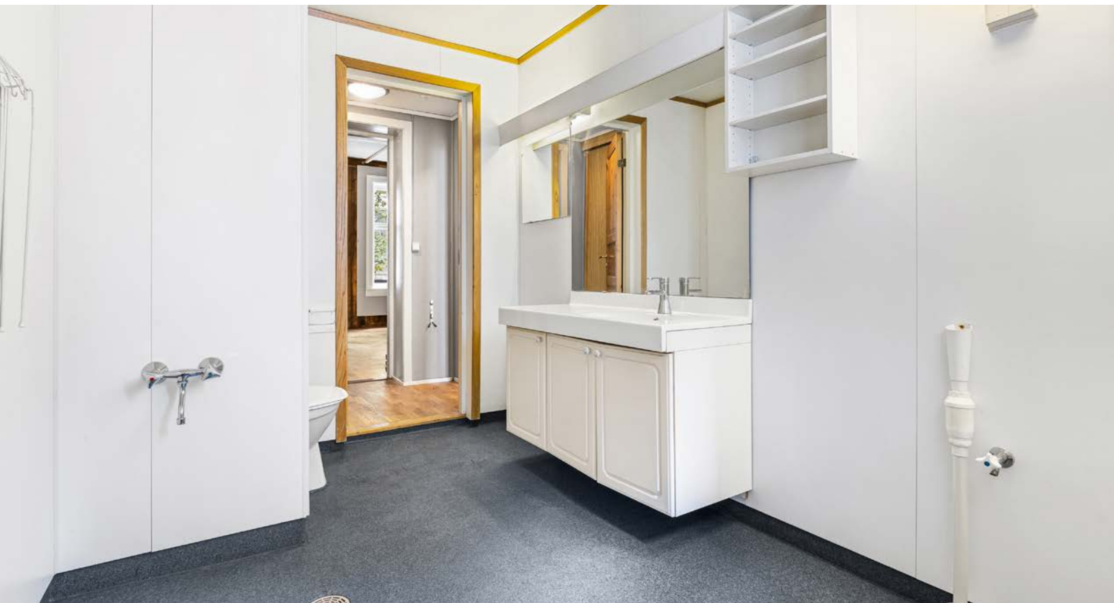
Baderomsinnredning med heldekkende servant på underskap og speil med belysning over, overskap, gulvstående wc og opplegg for vaskemaskin.
