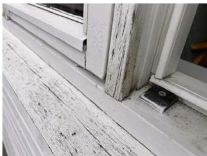
Råtskader i nedre del av vindu.
