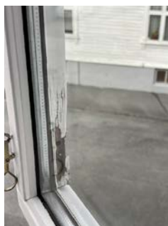
Råtskader i nedre del av vindu.
