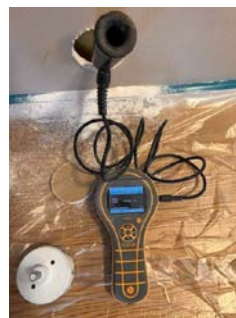
Fuktmåling i vegg mot våtsone.
