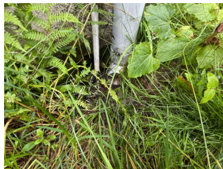
Nedløpet er avsluttet over terreng med utkaster.
