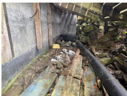
Utvendig fuktsikring er trekulltjære
