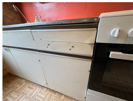
Skader og manglende håndtak.
