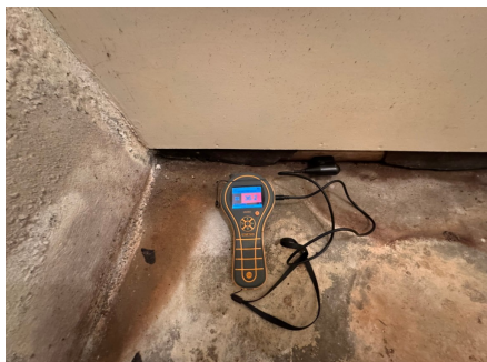
Observasjoner gjort i rom under terreng.
