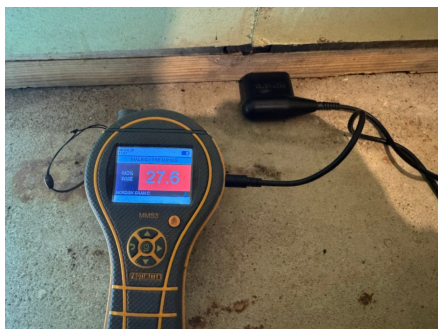
Fuktmåling i svill mot vaskerommet.
