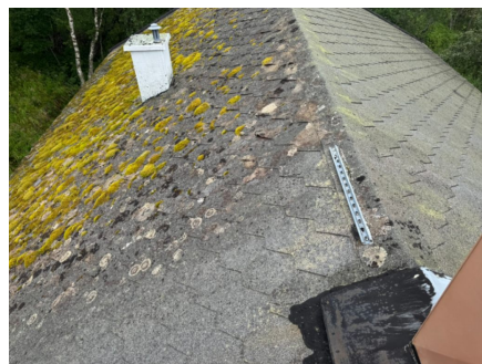
Takstigen er demontert.
