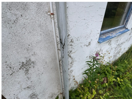
Skader på takrennenedløp.
