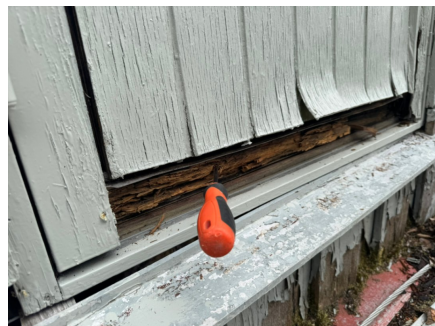
Råteskadet balkongdør.
