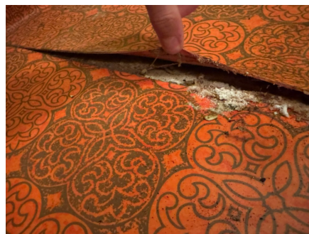
Utettheter i vinylbelegget.
