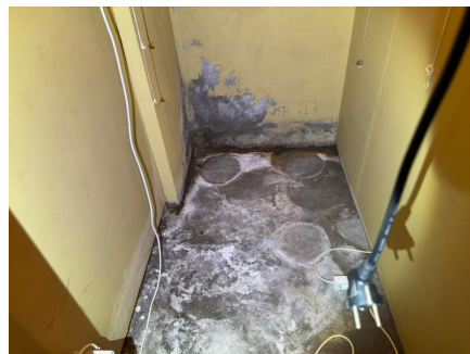
Observasjoner gjort i rom under terreng.
