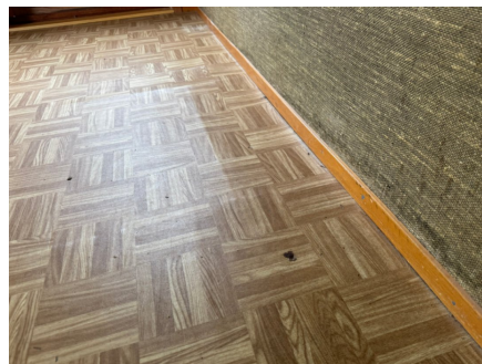
Synlige fuktskader i gulvet ved kjøkkenet.
