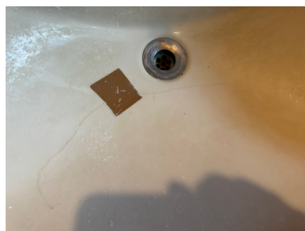
Sprekk i servanten.
