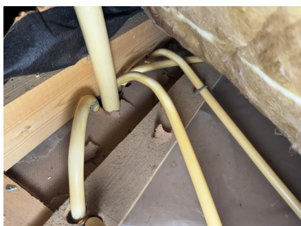
Eksempel på punktert dampsperre.
