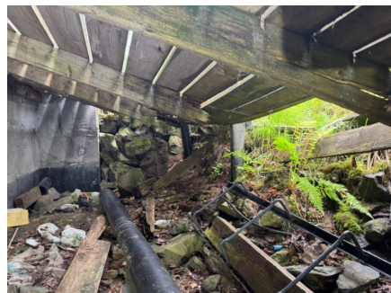
Råteskadet bærebjelker.
