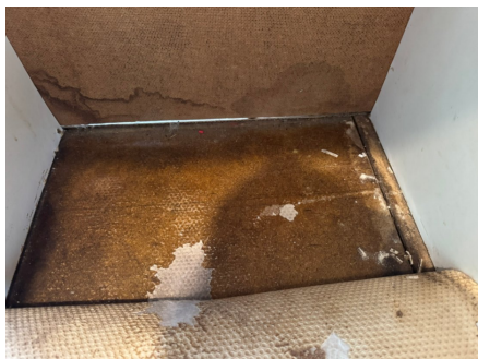
Synlige fuktskader i gulvet ved kjøkkenet.
