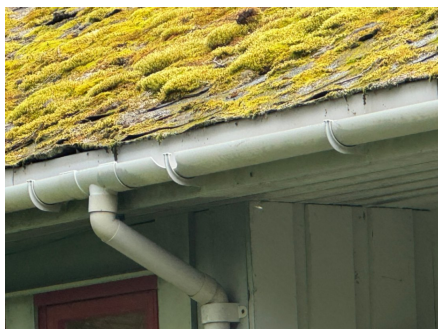
Skader på takrennenedløp.
