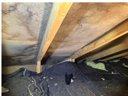
Avluften er avsluttet på kaldloftet.
