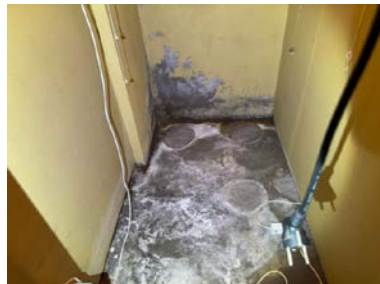
Observasjoner gjort i rom under terreng.
