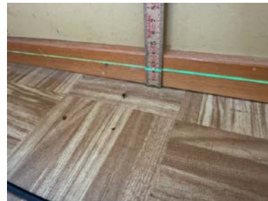
Synlige fuktskader i gulvet ved kjøkkenet.
