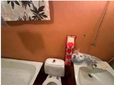
Sprekk i grunnmuren på badet.
