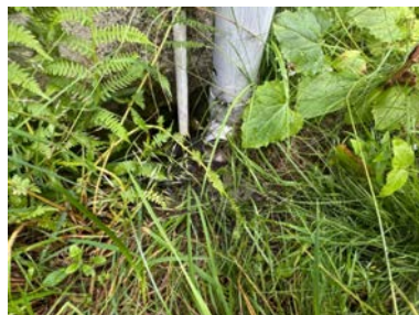
Nedløpet er avsluttet over terreng med utkaster.
