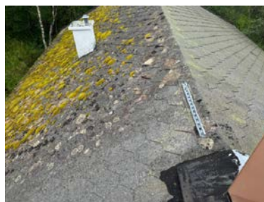
Takstigen er demontert.
