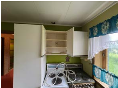
Ventilatoren er demontert.
