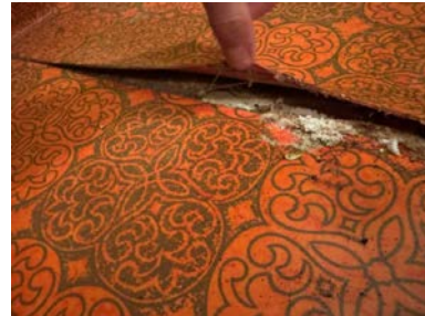
Utettheter i vinylbelegget.
