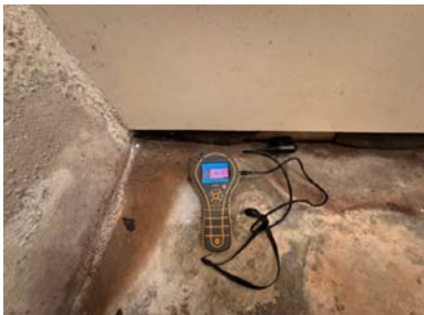
Observasjoner gjort i rom under terreng.
