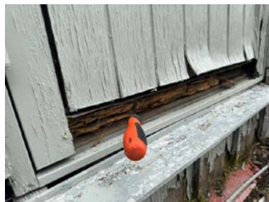
Råteskadet balkongdør.
