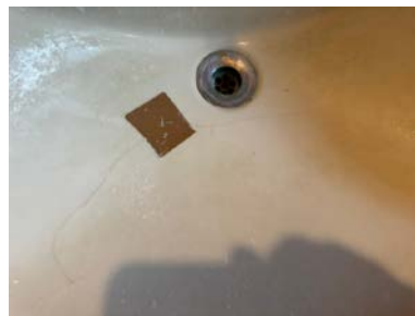
Sprekk i servanten.
