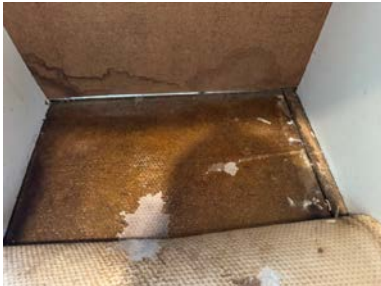
Synlige fuktskader i gulvet ved kjøkkenet.
