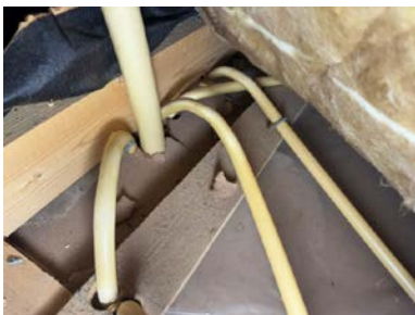
Eksempel på punktert dampsperre.
