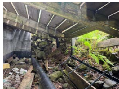
Råteskadet bærebjelker.
