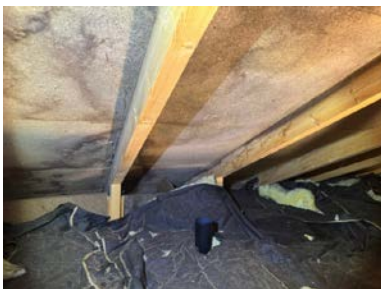
Avluften er avsluttet på kaldloftet.
