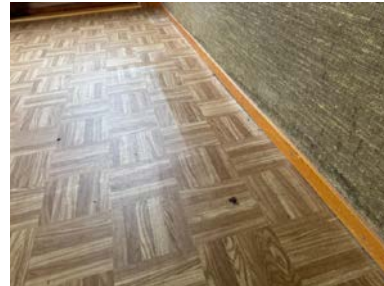
Synlige fuktskader i gulvet ved kjøkkenet.
