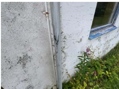
Skader på takrennenedløp.
