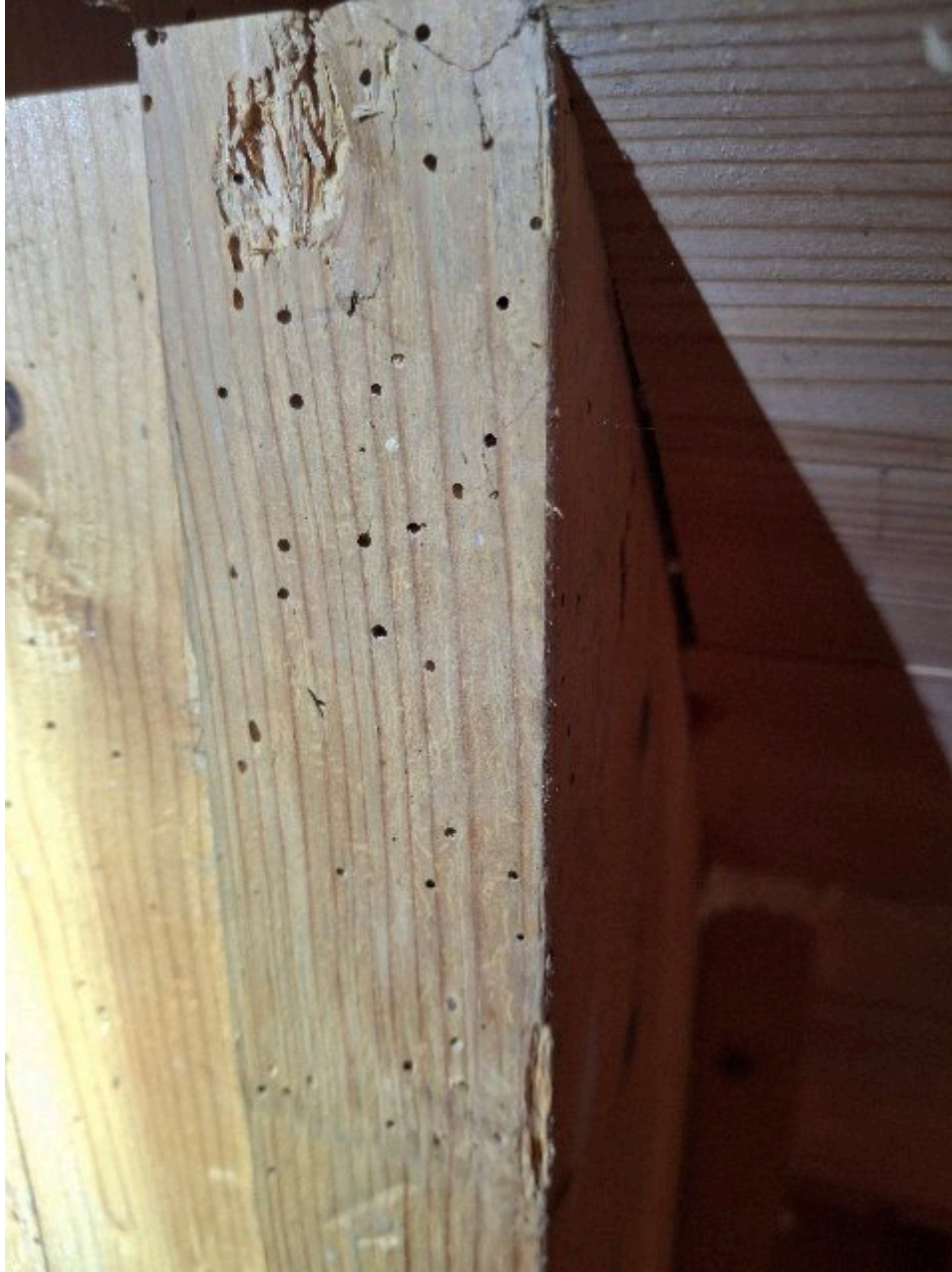
Flyvehull under trapp kjeller
