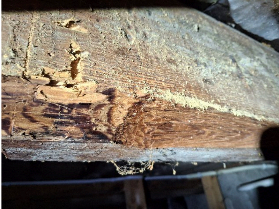
Skade på bjelke
