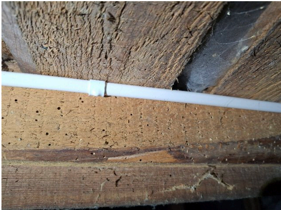
Skade på bjelke
