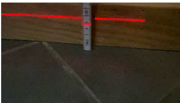
Høyde gulv ved dør.
