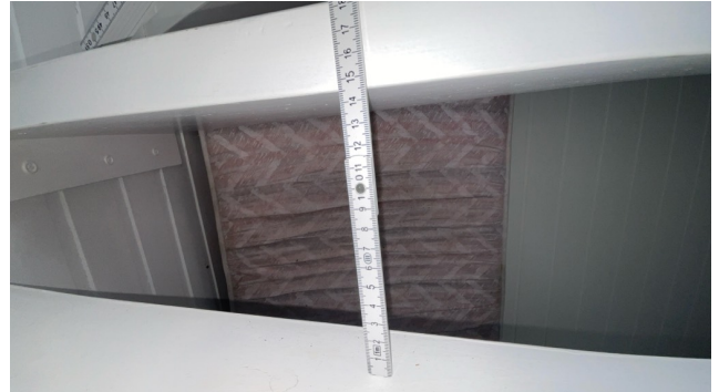
Åpninger mellom trinn er 14,5 cm.
