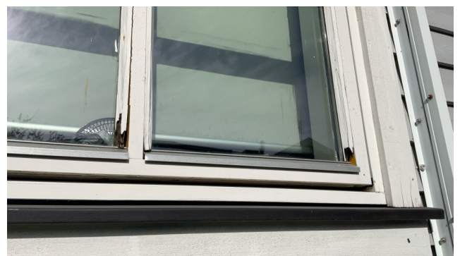
Råteskader sprosser.
