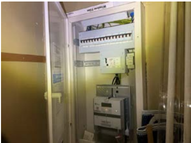
El-anlegg med automatsikringer. I hovedsak skjult ledningsnett. Sikringsskapet er plassert i bod.
