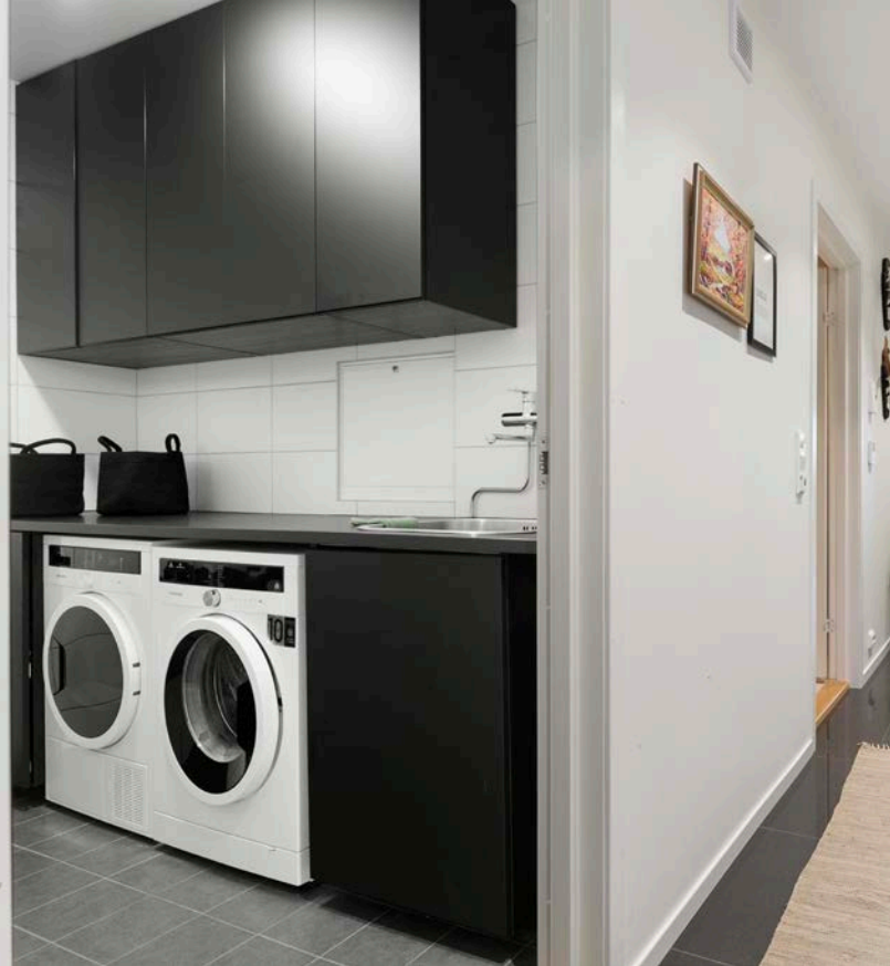
Vaskerommet har flislagte gulv og vegger, innredning med utslagskum og opplegg for vaskemaskin.
