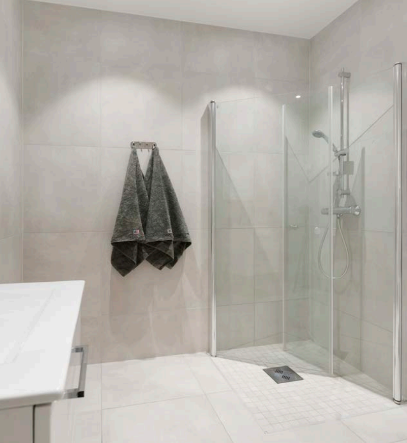
Badet i 1. etasje er flislagt med elektriske varmekabler, malt tak og balansert ventilasjon.
