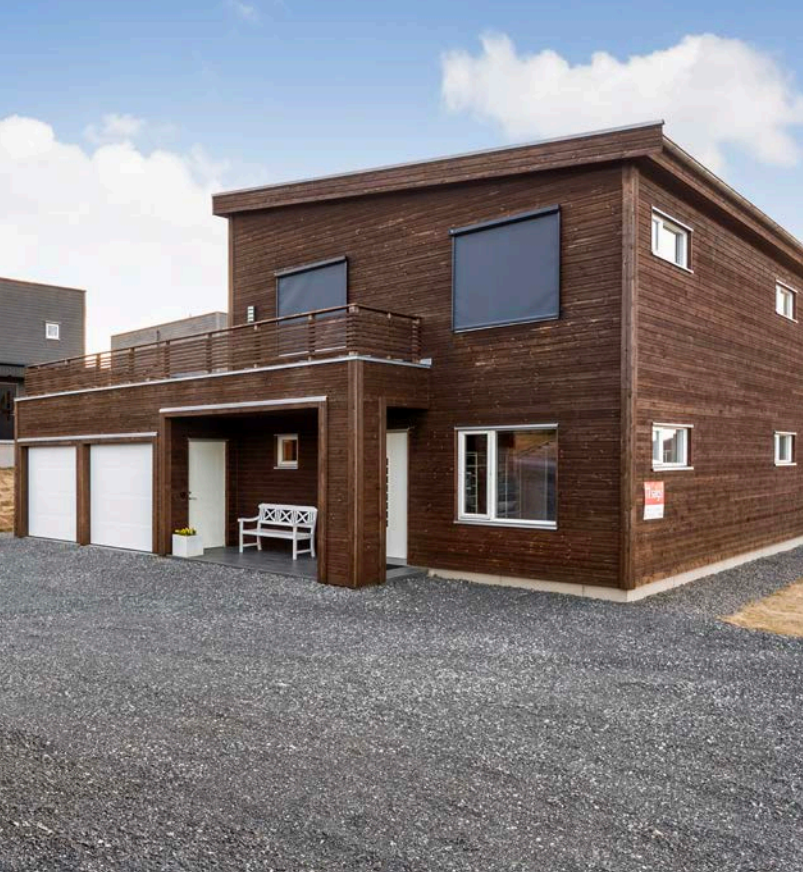
Innbydende og overbygd inngangsparti m/ downlights.
