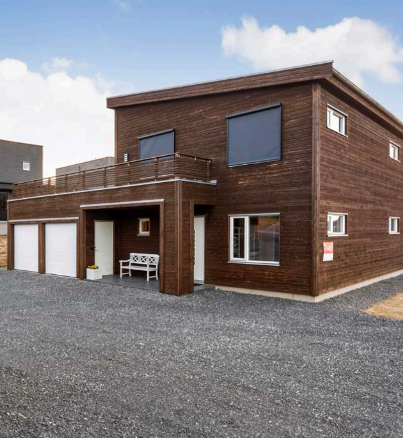
Innbydende og overbygd inngangsparti m/ downlights.
