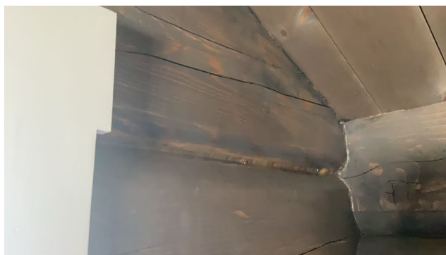
Foretatt tetting av utettheter/glipper
