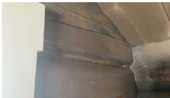
Foretatt tetting av utettheter/glipper
