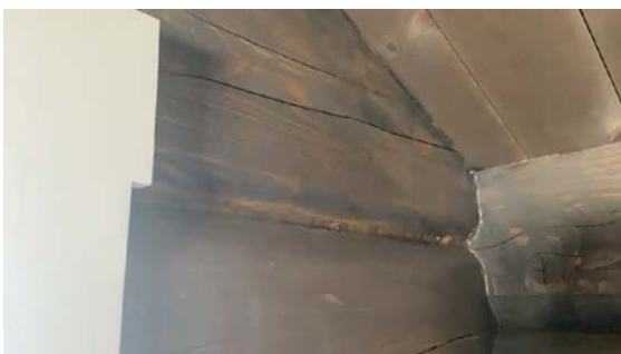
Foretatt tetting av utettheter/glipper
