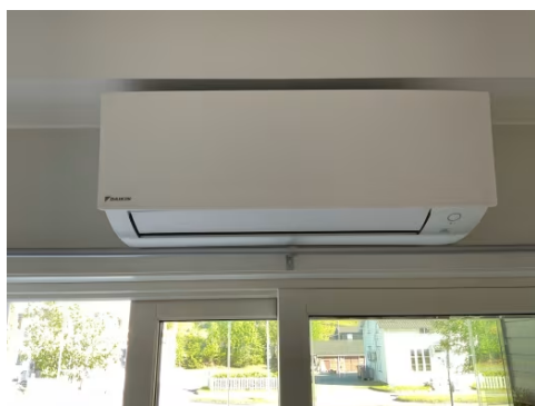
Varmepumpe.
