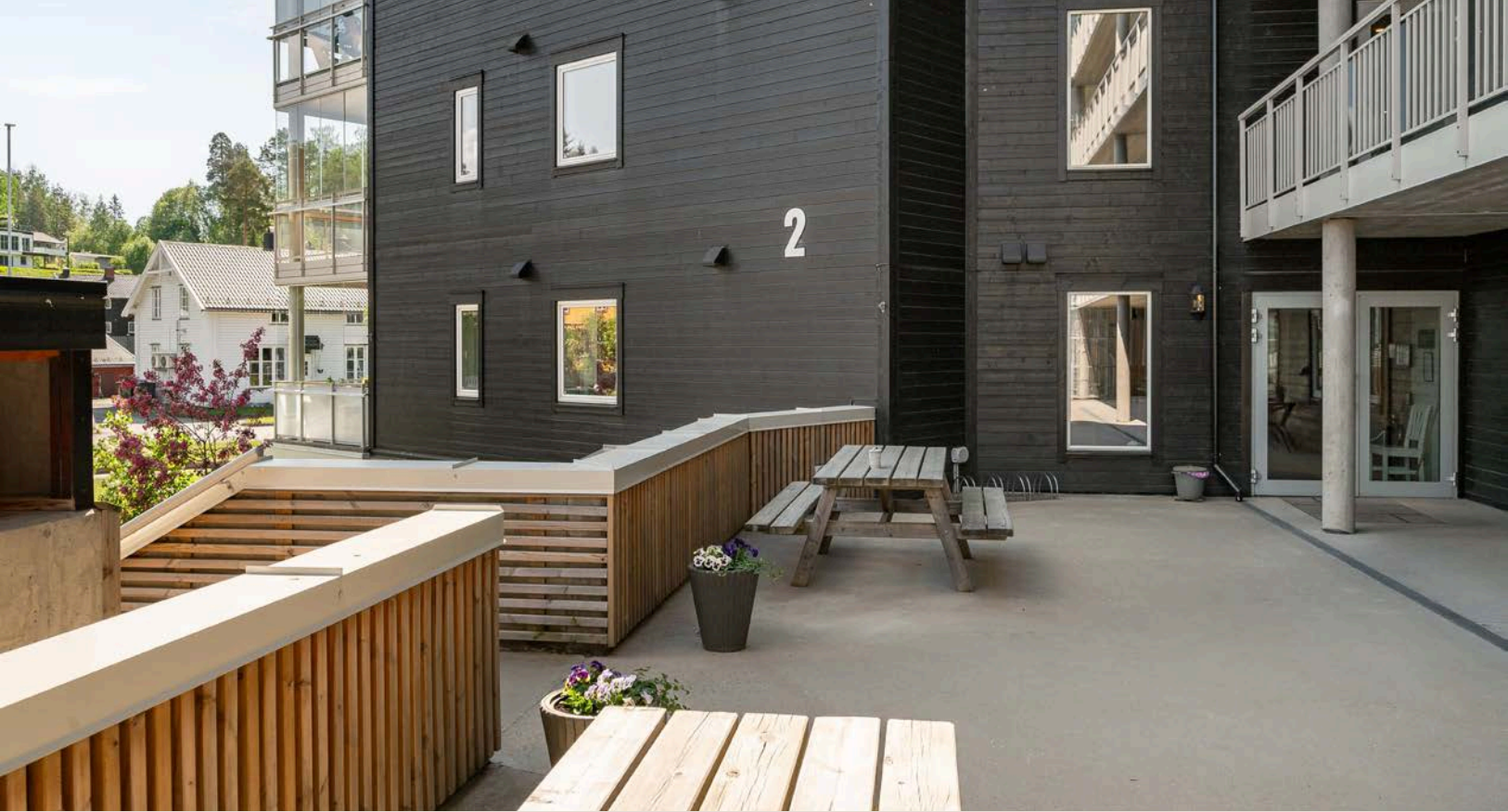
Ryddige og pent opparbeidede fellesarealer med sittegrupper og beplantning.
