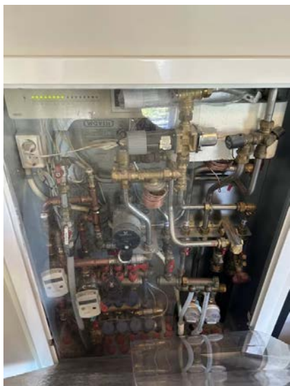
Fordelerskap for vann og vannbåren varme.
