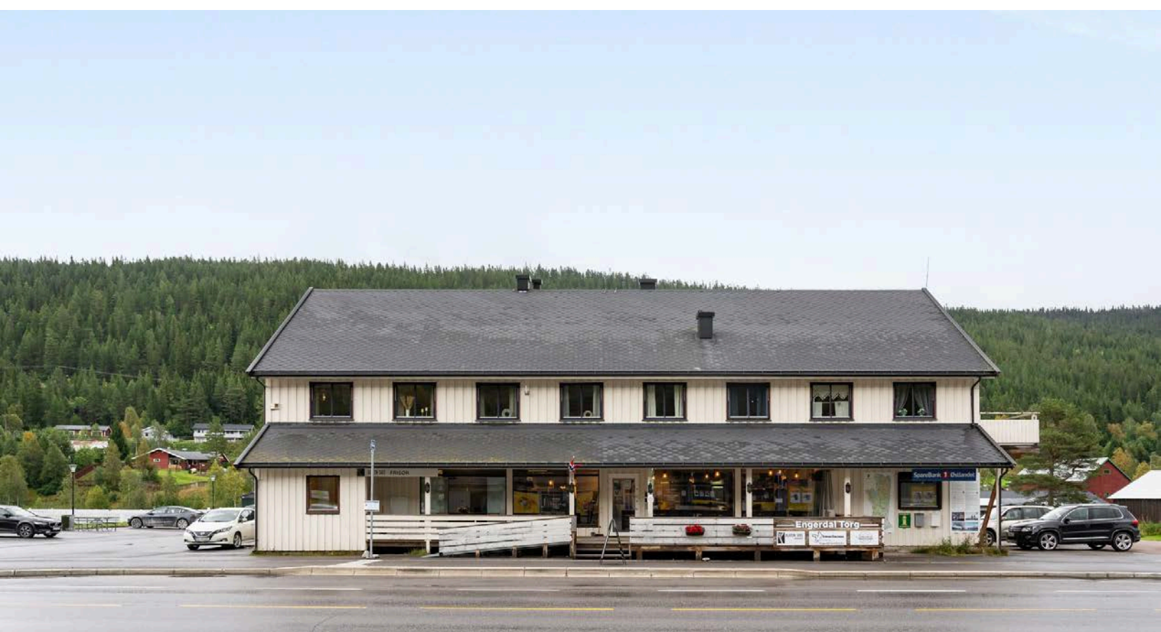
Næringsbygg med 2 etasjer, kjeller og loft. Kombinert næringsbygg med forretningslokaler og leiligheter samt tekniske rom.
