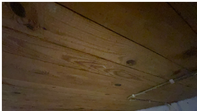
Spor etter murr/stripte borebiller i treverk i kjeller.
