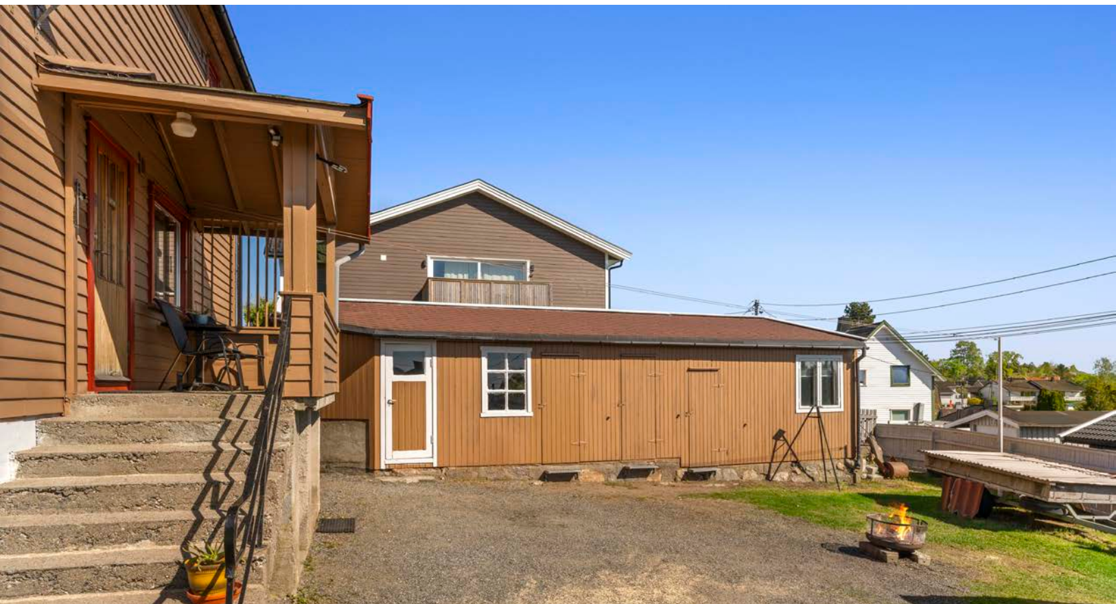
Betongstøpt trapp fører opp til boligens inngangsparti
