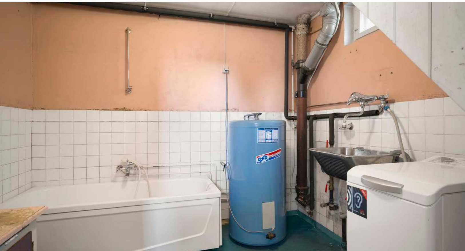
Badet i kjelleren har badekar og skyllekar, med belegg på gulv og vegger av mur og fliser.
