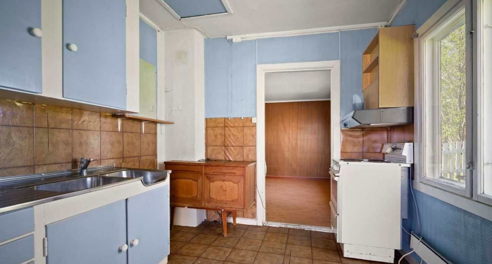
Kjøkkenet i annekset har eldre innredning med glatte fronter og kjøkkenventilator med avtrekk ut.
