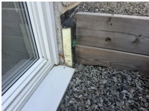
Det registreres utvendig grunnmursisolasjon og grunnmursplast.
