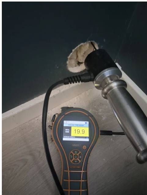
Bilde fra fuktmåling i utlektet veggkonstruksjon.
