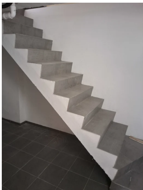
Flislagt betongtrapp mellom kjelleretasje og 1. etasje.
