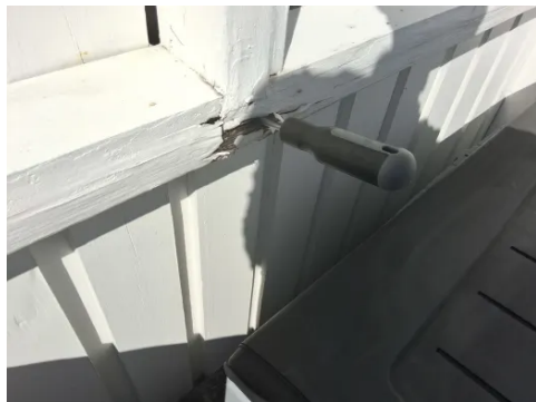
Råteskadet rekkverk.
