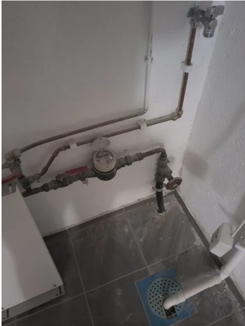
Hovedstoppekrane er plassert i kjellergang.
