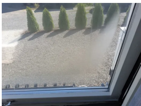
Punkttert vindu på soverom.
