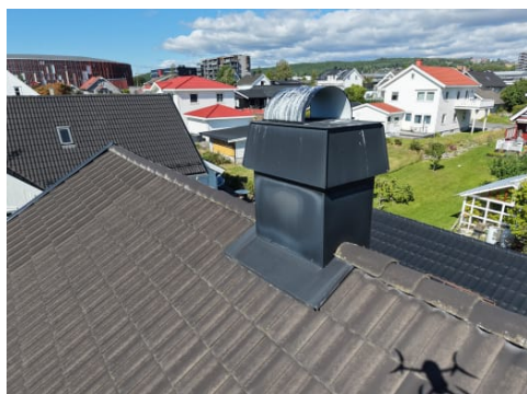
Pipen er kledd med heldekkende beslag.
