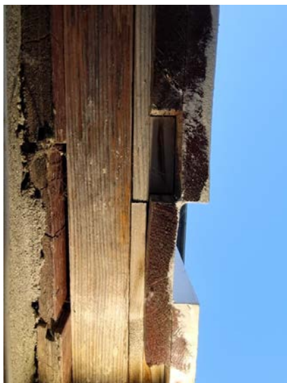
Bilde viser original kledning påmontert lekter og ny kledning.
