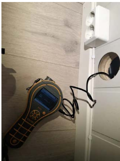
Bilde fra fuktmåling i veggkonstruksjon tilstøtende våtsone.
