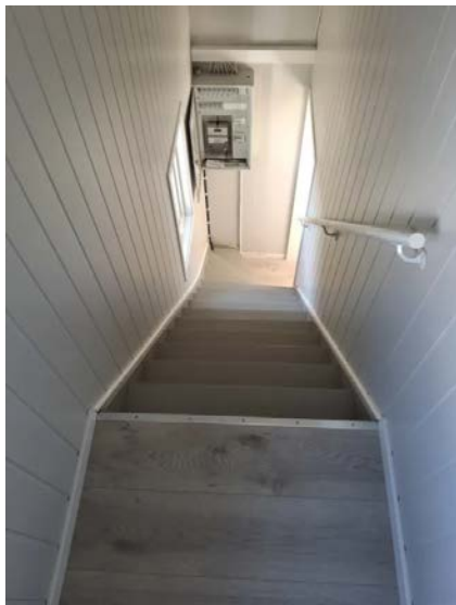
Lukket tretrapp mellom 1. etasje og loftsetasje.
