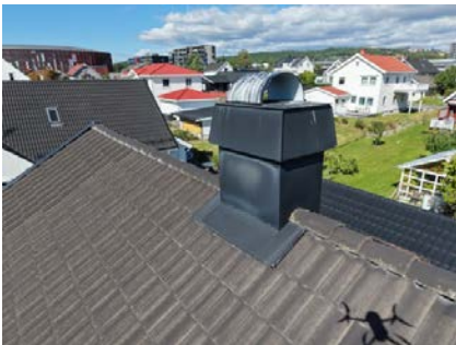
Pipen er kledd med heldekkende beslag.
