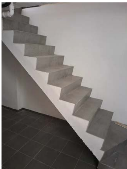
Flislagt betongtrapp mellom kjelleretasje og 1. etasje.
