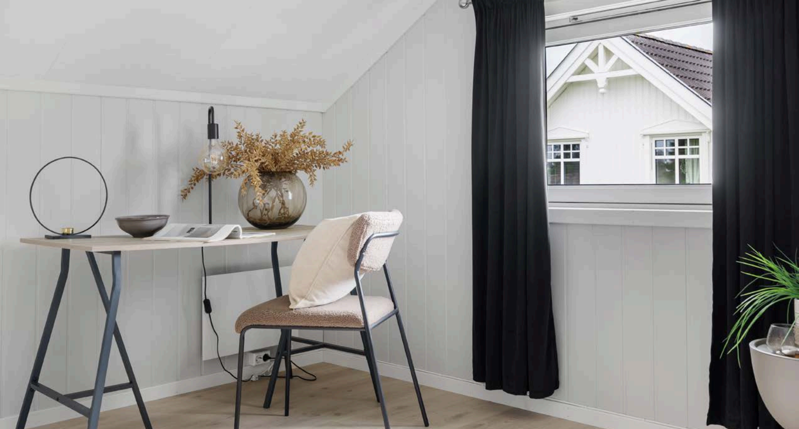
Etasjen varmes opp med elektriske panelovner.
