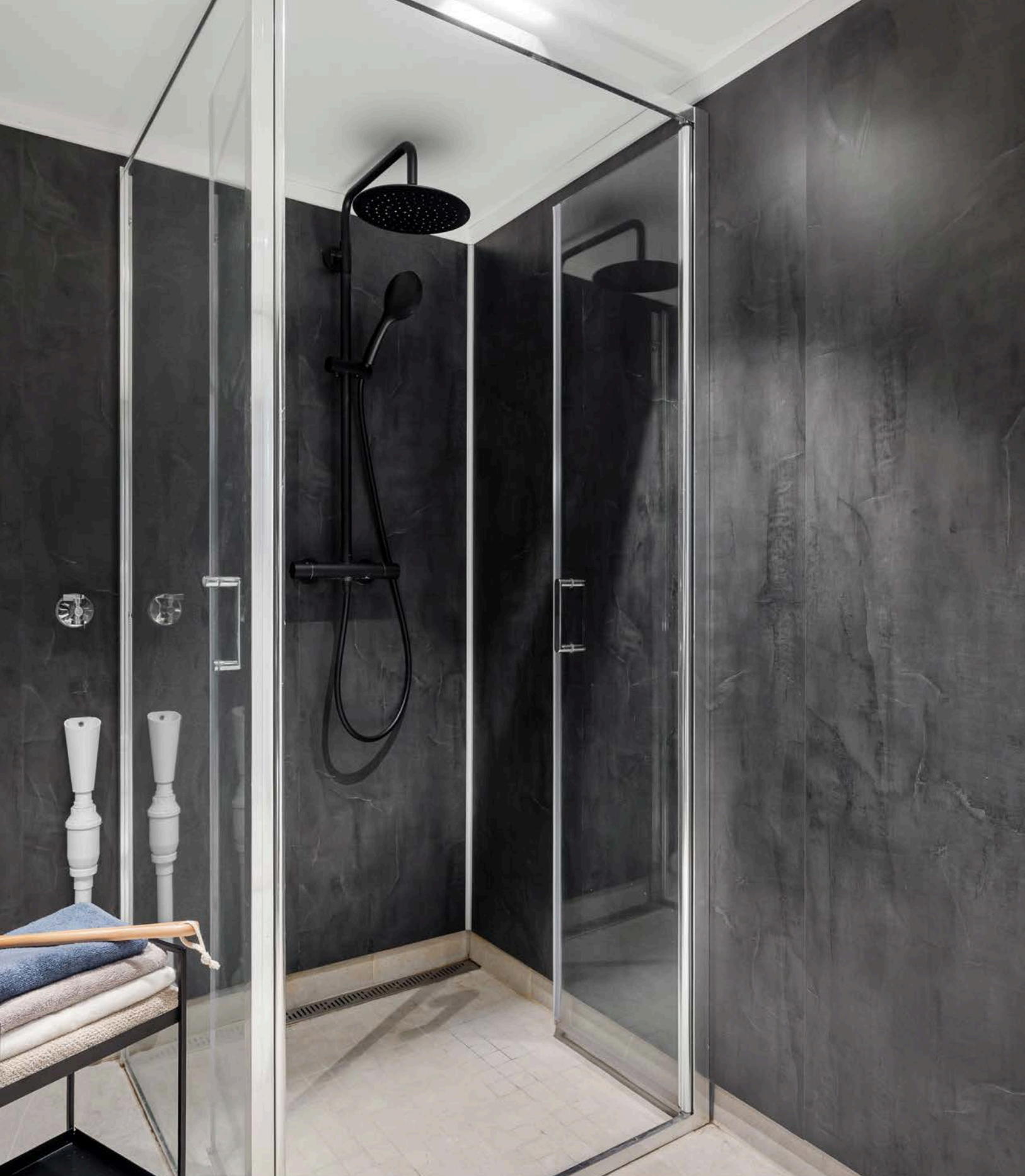
Dusjhjørne med dusjvegger og veggmontert dusjbatteri.
