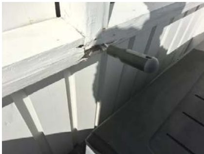
Råteskadet rekkeverk.
