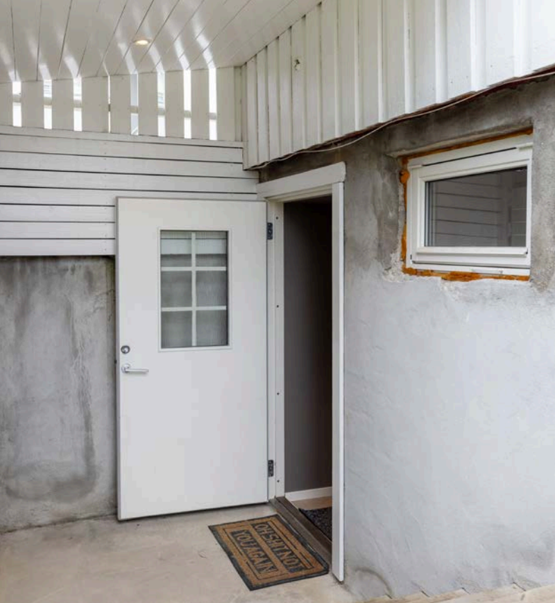
Egen inngang til kjelleren med takoverbygd inngangsparti.
