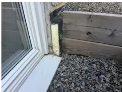
Det registreres utvendig grunnmursisolasjon og grunnmursplast.
