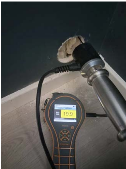
Bilde fra fuktmåling i utlektet veggkonstruksjon.
