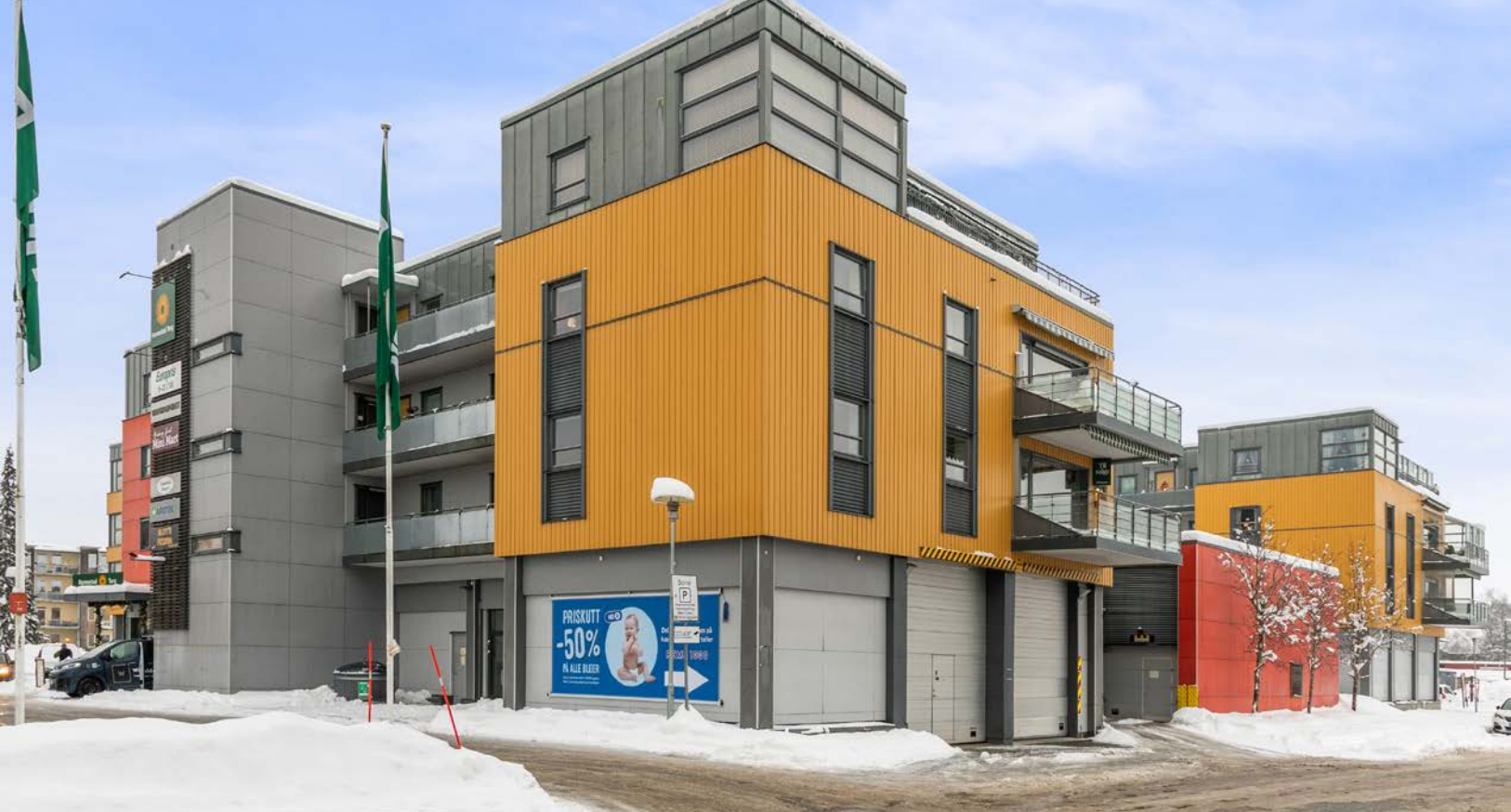
Leiligheten ligger over Nannestad Torg, og det er tilhørende garasjeanlegg i bygget.
