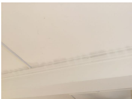
Heksesot eller støvkondens på flere overflater.
