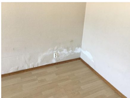
Saltutslag på vegger registrert. Ved fuktøk ble det registrert unormale verdier. Fuktskjolder i himling.
