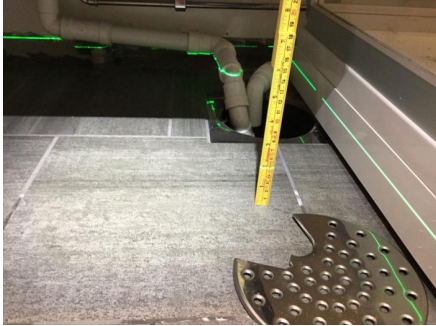
Gulv er flatt og det er ikke fall til sluk i aktiv vannsone.
