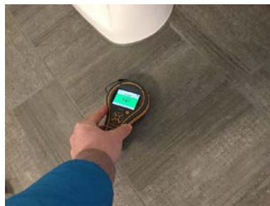
Med enkle fuksøk ble det ikke registrert unormale verdier.
