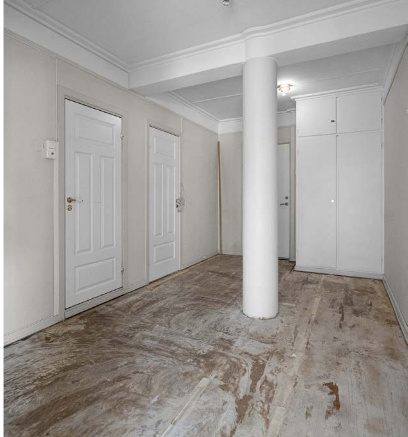
Takstmann opplyser at overflater var tørre ved befarig unntatt på ene soverom.
