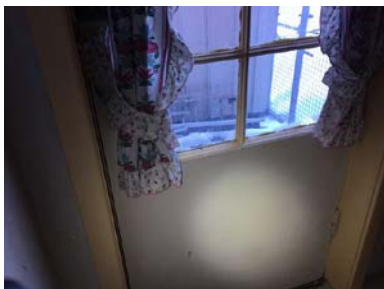
Ytterdør mot bakdør har slitasje og er utett.
