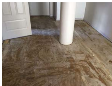
Overflater er fjernet på flere gulv.
