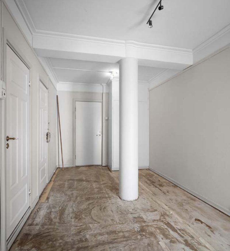
Leilighet har tidligere hatt vannskade og overflater på gulv ble fjernet i flere rom. Det er nå lagt nytt gulv.
