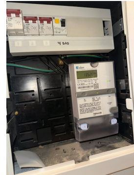
Sikringskapp med automatsikringer.
