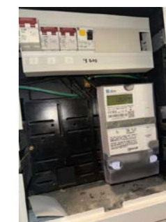
Sikringsskap med automatsikringer.
