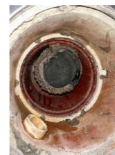
Plastsluk med klemring for membran
