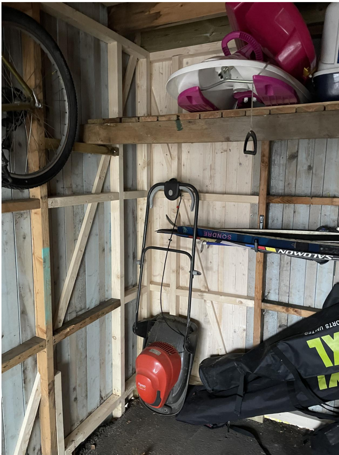
Utbedret garasjerom etter råteskadet kledning og konstruksjon.
