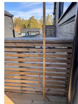
Rekkverk til terrasse over støttemur er målt til 74
