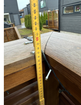
Topp rekkverk målt til ca 97cm
