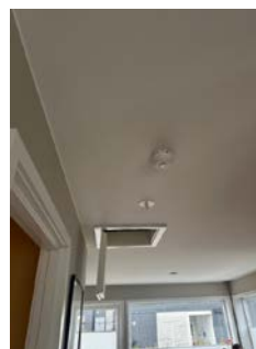
Røykvarsler. Det er montert 1 stk pr etasje. Disse fungerte på befaringstidspunktet
