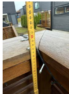
Topp rekkverk målt til ca 97cm
