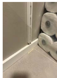
Flis i Bod/Teknisk rom som er fuget
