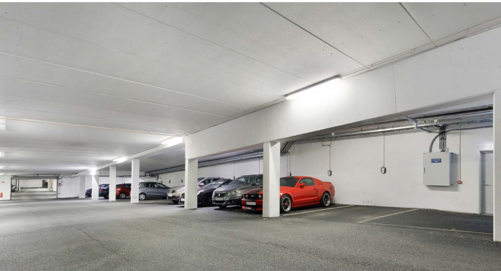
Parkeringsplass nær trapperom og heis.
