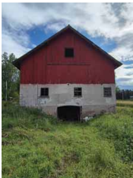
Gavlvegg mot vest
