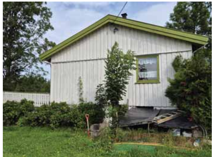
Fasade mot sør og kjellernedgang til fyrrom
