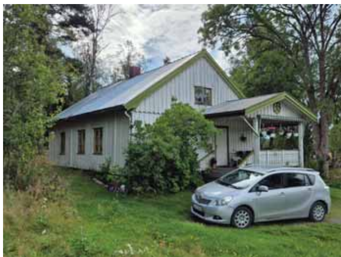
Nordvegg og gavlvegg mot vest
