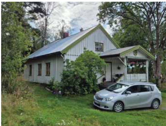
Nordvegg og gavlvegg mot vest
