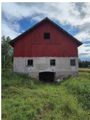
Gavlvegg mot vest
