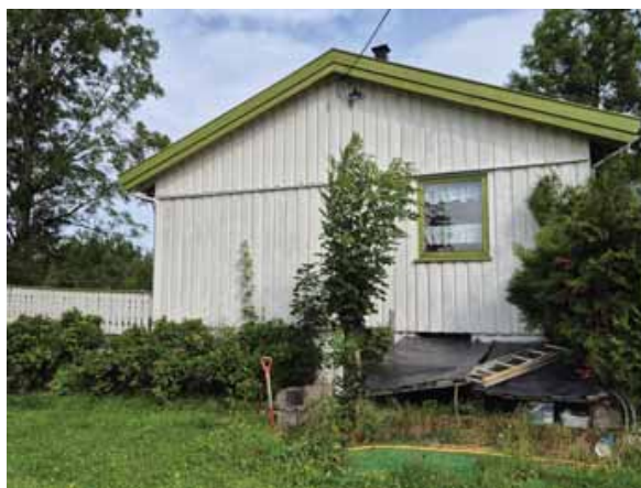
Fasade mot sør og kjellernedgang til fyrrom
