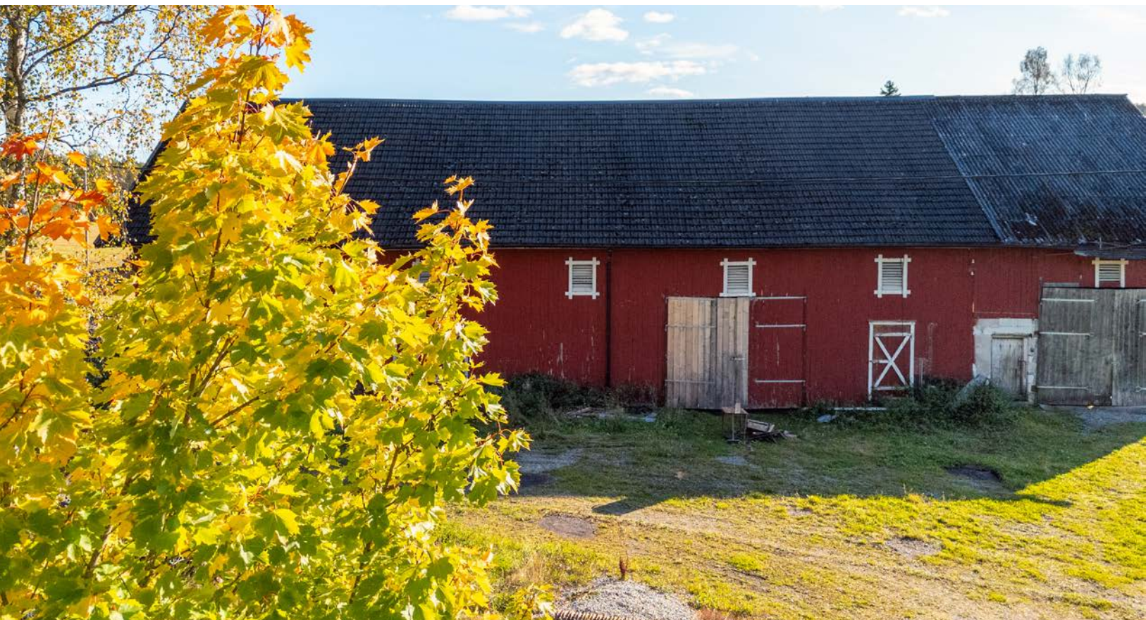
Innvendig er fjøs gjort om til delvis isolert lager/garasje. Bygningen har lite synlige skader eller mangler på fundamentering og bæring, men har behov for omfattende renovering.
