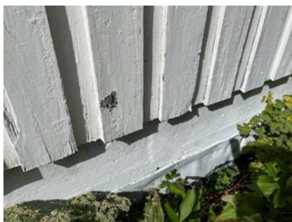
Spredte råteskader
