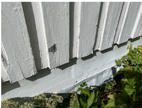
Spredte råteskader
