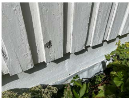
Spredte råteskader
