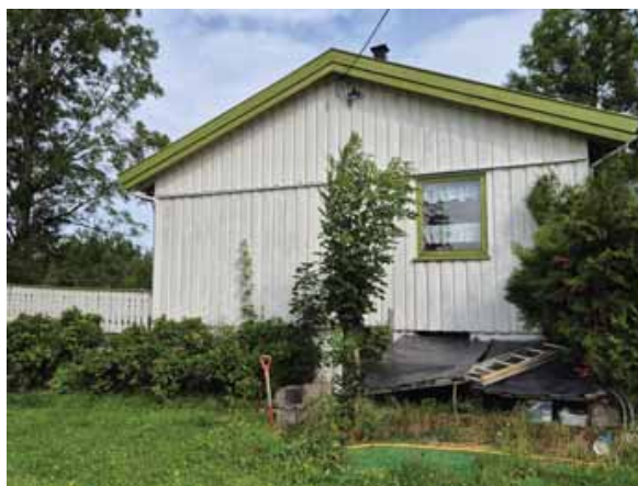
Fasade mot sør og kjellernedgang til fyrrom
