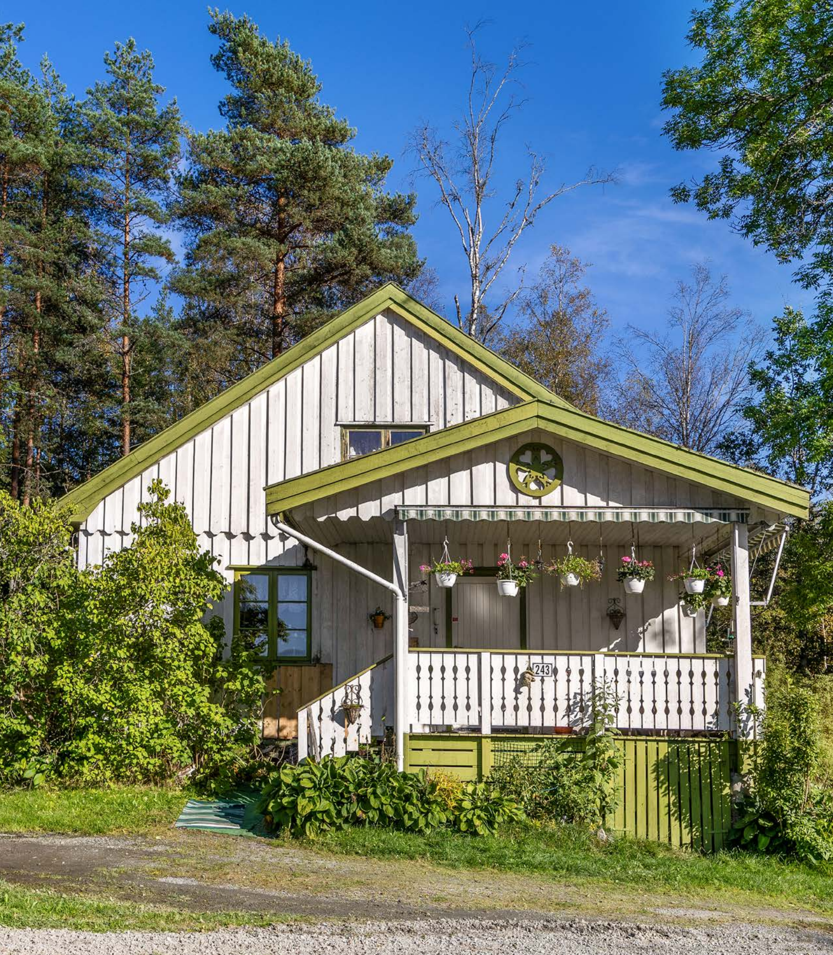
Nedre Dalsroen 243 har en overbygd og trivelig adkomstveranda.
