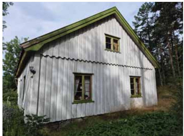
Gavlvegg mot øst
