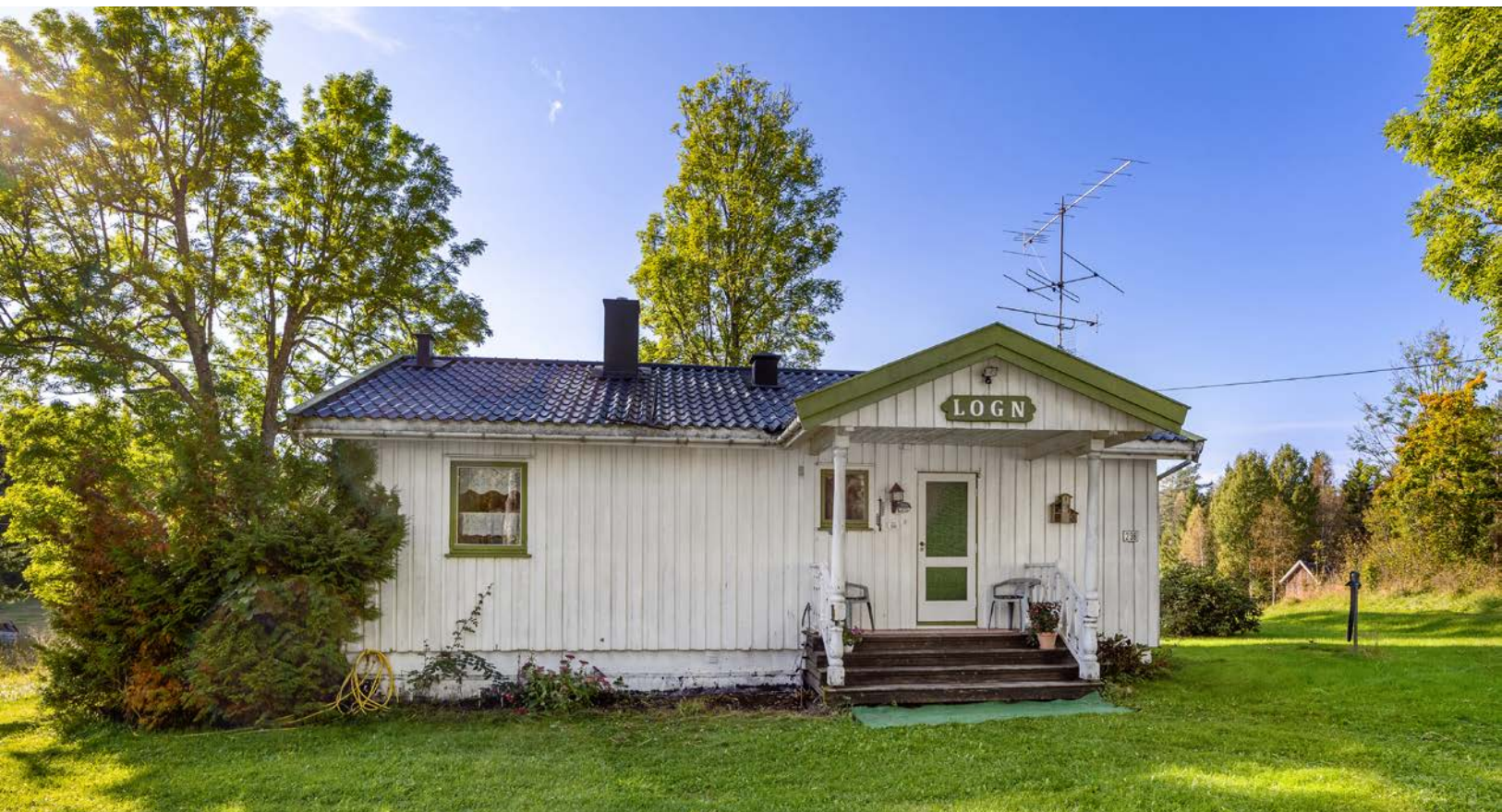
Nedre Dalsroen 236 har et inngangsparti med overbygg og belysning.
