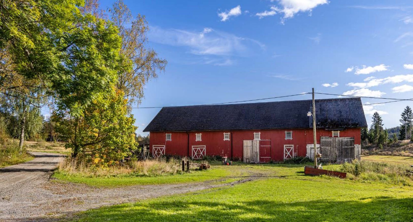
Driftsbygningen fra 1936 brukes i dag som lager. Det er fjøs fra 1955 med støpte vegger i enden av bygningen, og med støpt gjødselkjeller under. Det er støpt låvebru i kjørbar stand. Innvendig kjørebri av tre.
