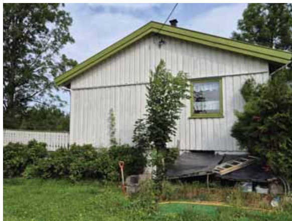
Fasade mot sør og kjellernedgang til fyrrom
