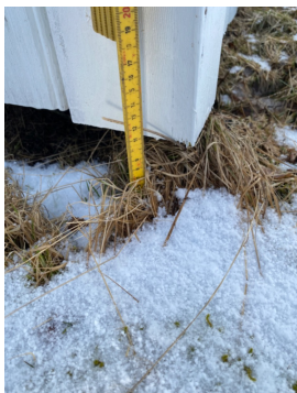
Åvstand bordkledning/terreng.
