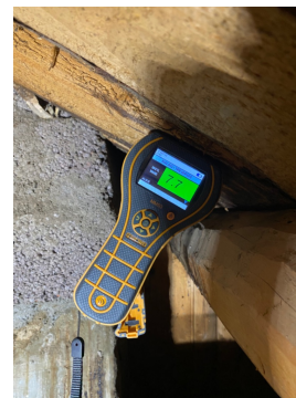
Fuktmåling i takkonstruksjon viste ingen forhøyede fuktverdier.
