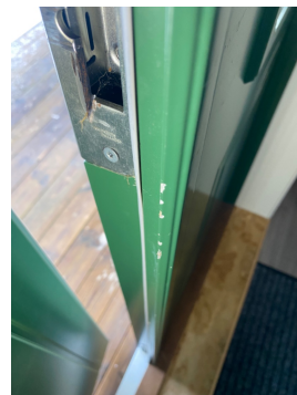
Døren har stedvis små overflateskader.
