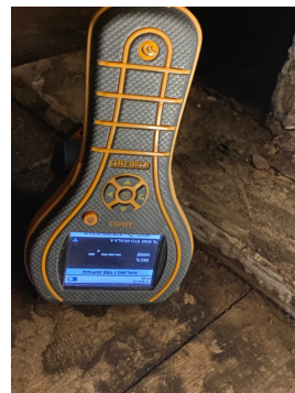
Fuktmåling i takkonstruksjon viste ingen forhøyede fuktverdier.
