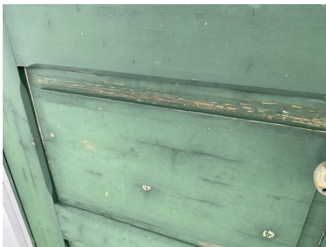
Værslitt overflate.
