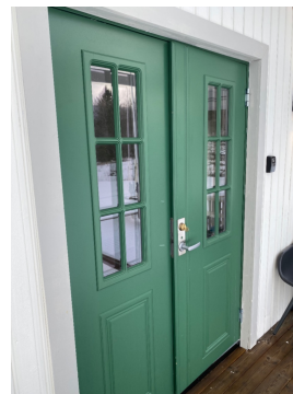
Døren har stedvis små overflateskader.
