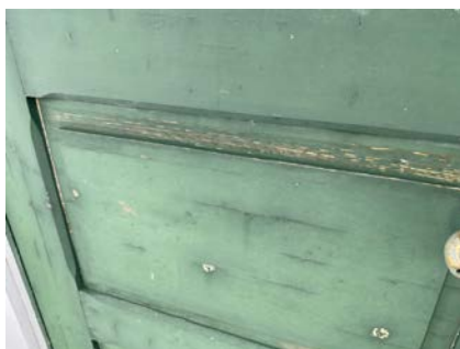
Værslitt overflate.
