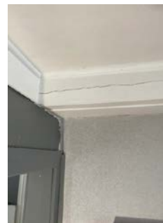
Gulvåser har stedvis sprekker.
