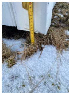
Avstand bordkledning/terreng.
