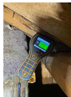
Fuktmåling i takkonstruksjon viste ingen forhøyede fuktverdier.
