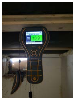
Fuktmåling foretatt med Protimeter MMS2 med pigger mot panel i taket. Det ble ikke registrert forhøyde verdier.
