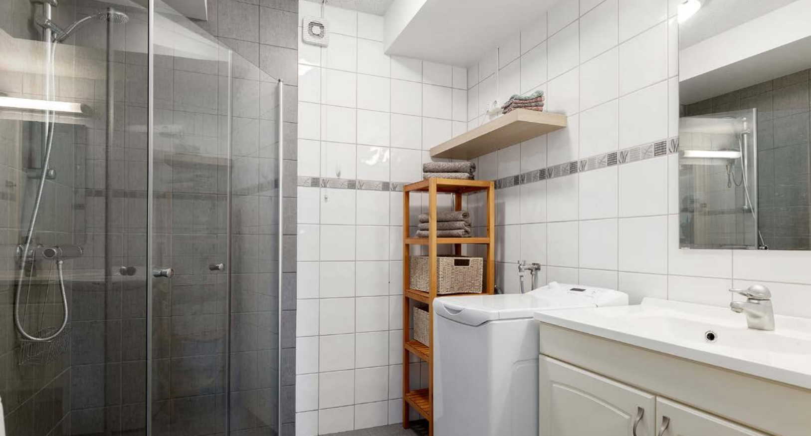
Bad/vaskerom i leiligheten fra byggeår. I 2020 ble membran og fliser på gulvet og vegger i dusjsone fornyet av fagfolk, samt montert nye dusjvegger.
