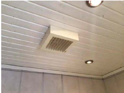
Montert avtrekk i tak.
