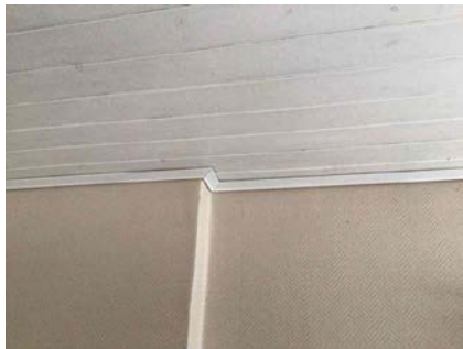
Del av innvendig overflate.
