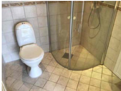
Montert dusjhjørne og wc.
