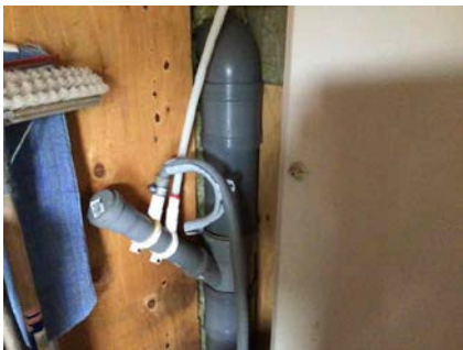
Lufting av avløp over tak.
