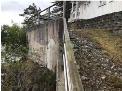
Forstøtningsmur i betong.
