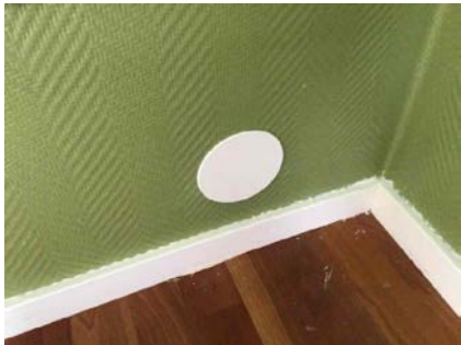
Hull for kontroll av fukt.
