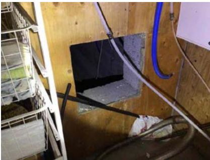
Luke fra teknisk rom inn til krypjkjeller.
