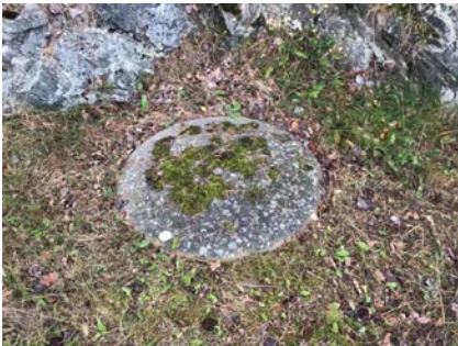
Lokk til walax renseanlegg.
