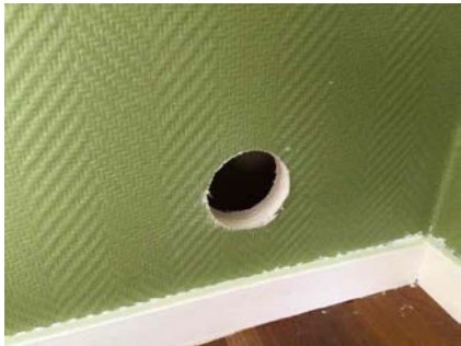
Hull for kontroll av fukt.
