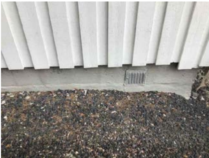
Del av grunnmur.
