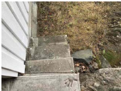
Utvendig trapp i betong.
