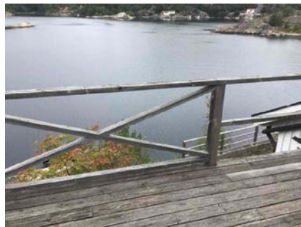
Rekkverk på terrasse.
