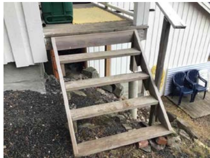
Utvendig trapp i tre.
