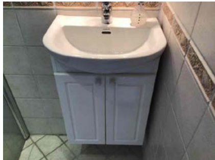
Montert innredning med vask.
