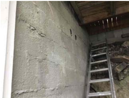
Del av grunnmur.
