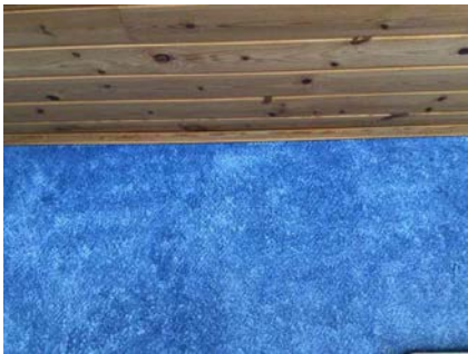
Del av innvendig overflate.
