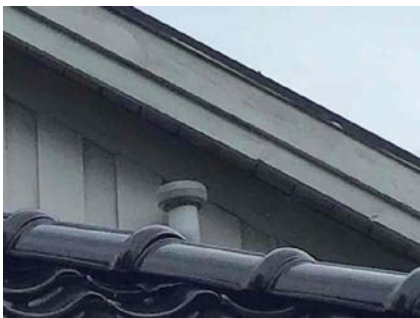
Lufting av avløp over tak.
