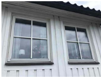
Eksempel på vindu i yttervegg.
