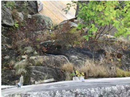
Utvendig vannrør til grunnvann.
