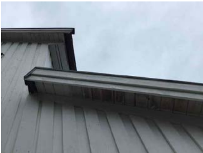
Takk ut stikk, her ser man del av undertak i bord.
