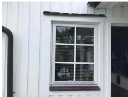
Eksempel på vindu i yttervegg.
