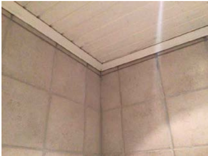
Del av overflater vegg - tak.
