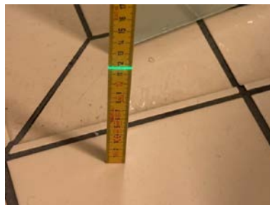
Fallforhold ca. 116 mm overkant gulv ved dusjsone
