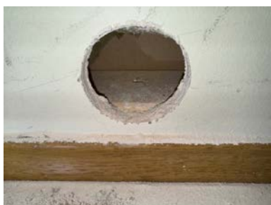
Hulltaking i tilstøtende soverom
