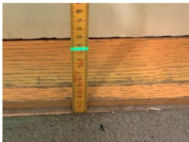
Fallforhold ca. 105 mm overkant gulv ved terskel
