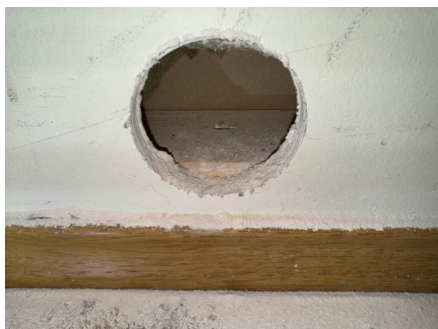
Hulltaking i tilstøtende soverom
