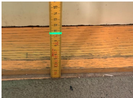
Fallforhold ca. 105 mm overkant gulv ved terskel
