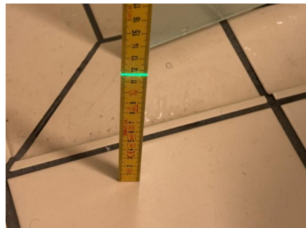
Fallforhold ca. 116 mm overkant gulv ved dusjsone
