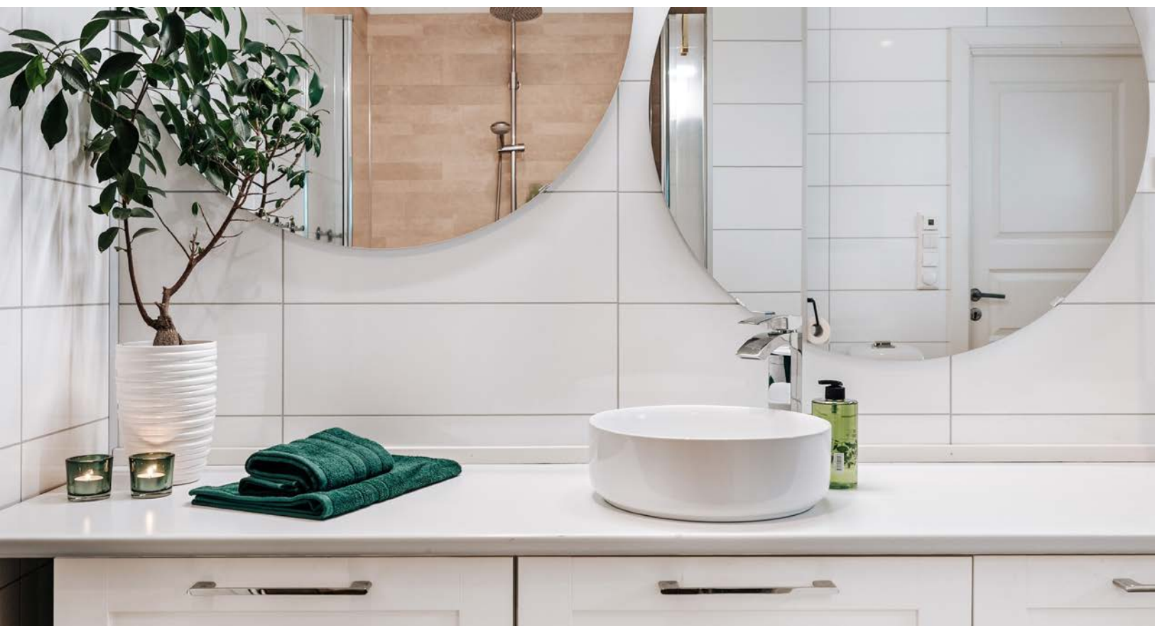
Lyst bad med baderomsplater og våtromstapet på veggene og belegg på gulvet. I gulvet er det elektriske varmekabler.
