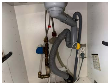
Rørapplegg i kjøkkenbenk med Waterguard
