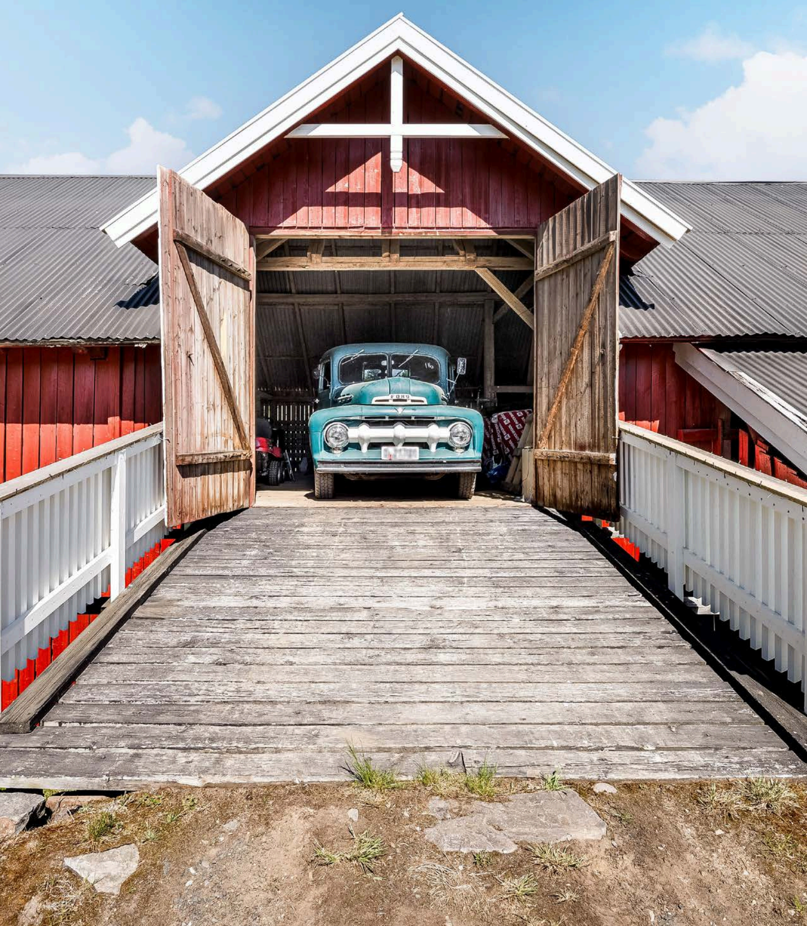
Låvebru av stablet naturstein og trekonstruksjoner. Fra låvebruen er det adkomst til 2. etasje som består av et stort lagerrom på 173 m 2 .
