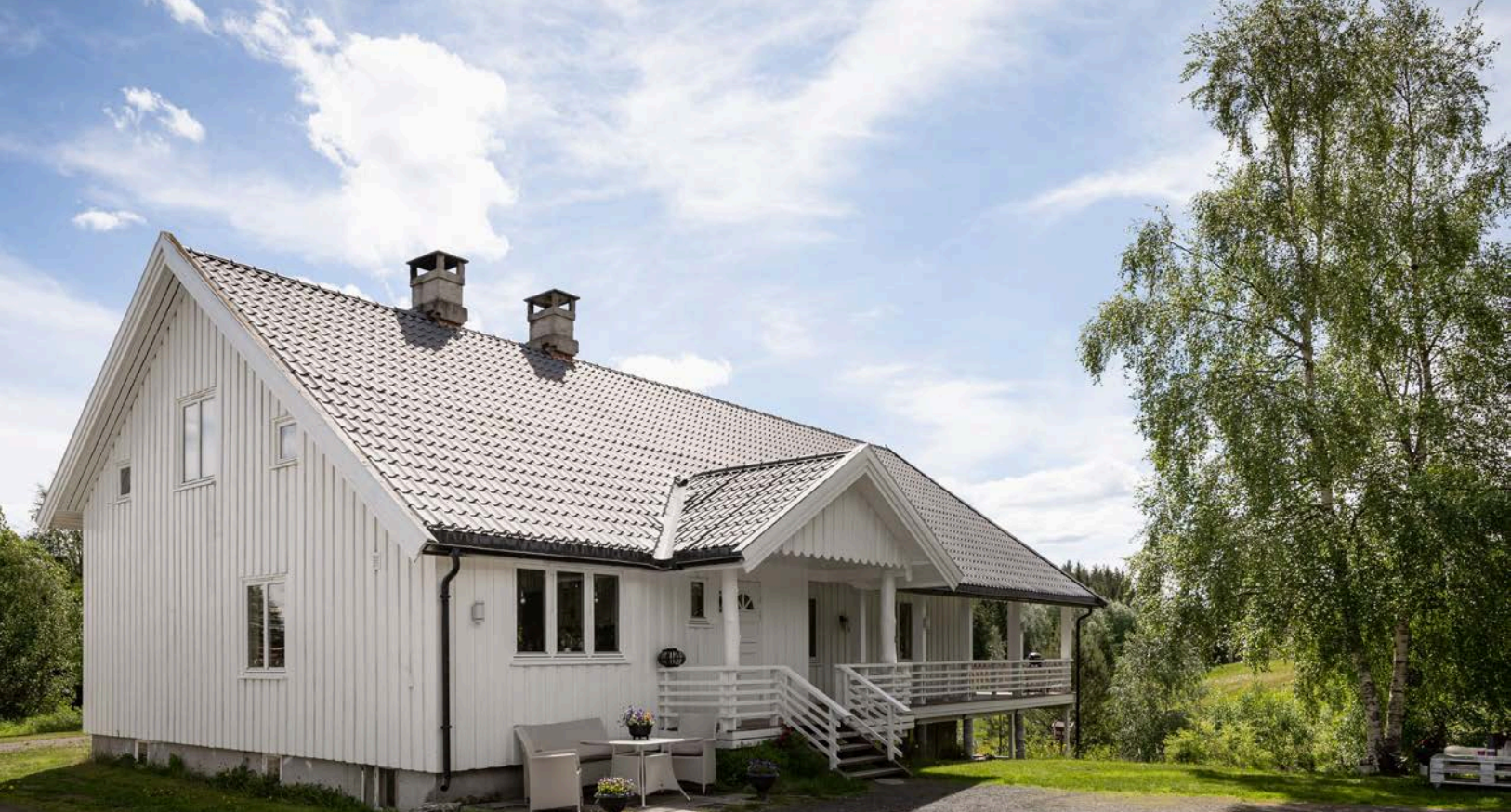
Under terrassen er det inngang til utleieleiligheten som er registrert som egen bruksenhet.
