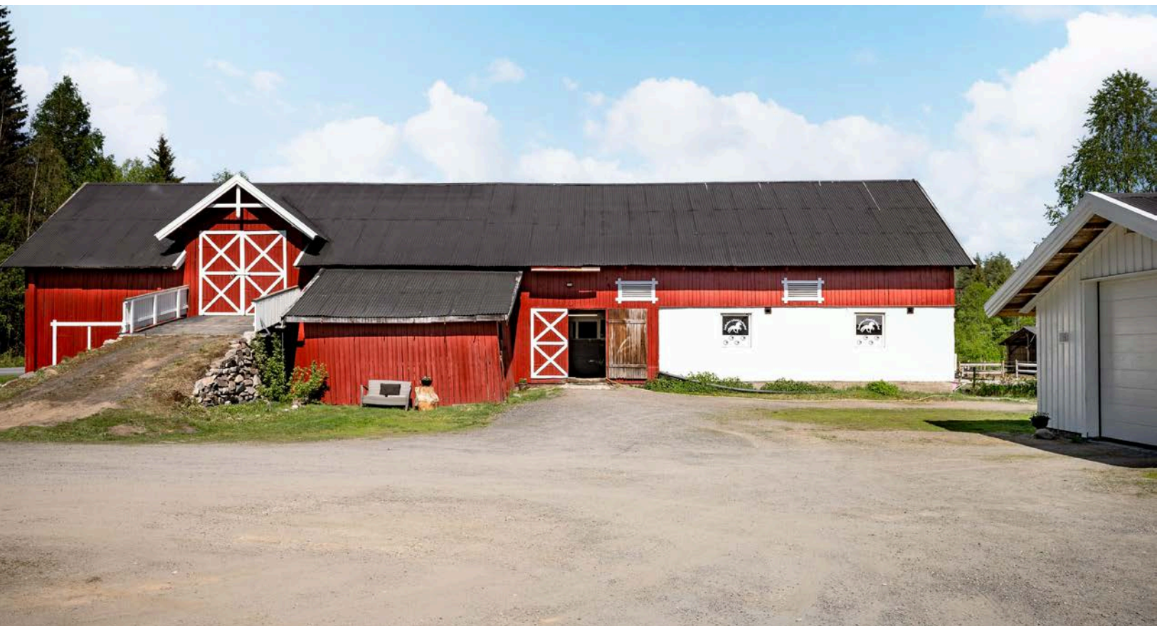
Eiendommen er også bebygd med en stor låve fra 1935. Låven har et bruksareal på 413m 2 og inneholder 2 staller og flere lagerrom.
