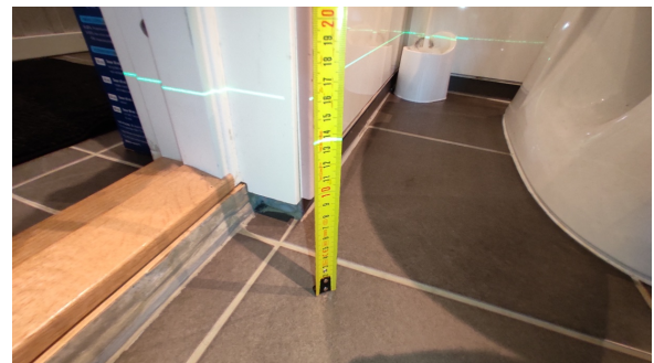
Kontroll av fallforhold.
