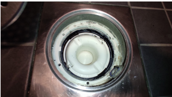
Kontroll av sluk.
