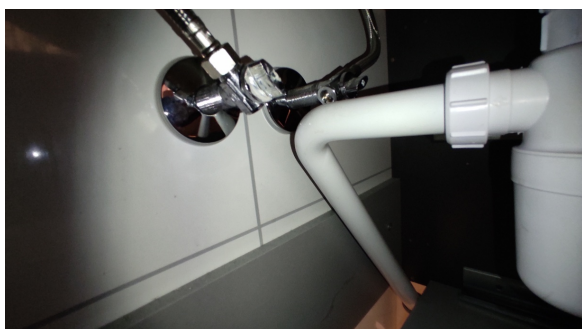
Kontroll av røropplegg.
