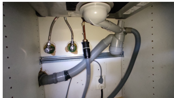
Kontroll av røropplegg.
