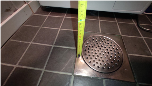
Kontroll av fallforhold.
