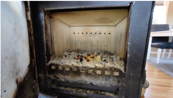
Kontroll av ildsted.
