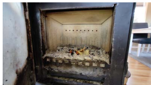
Kontroll av ildsted.
