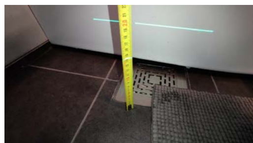
Kontroll av fallforhold.
