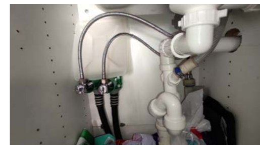
Kontroll av røropplegg.
