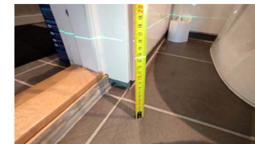
Kontroll av fallforhold.
