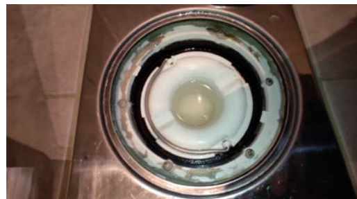
Kontroll av sluk.
