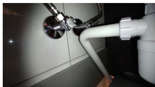
Kontroll av røropplegg.
