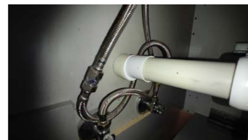
Kontroll av røropplegg.
