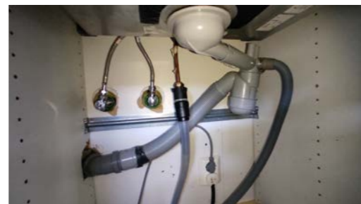
Kontroll av røropplegg.
