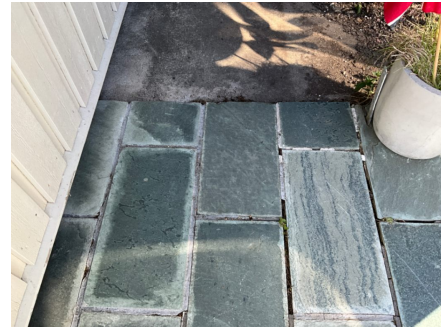
Flere løse skifer fliser.
