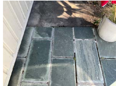
Flere løse skifer fliser.
