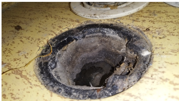
Kontroll av sluken.
